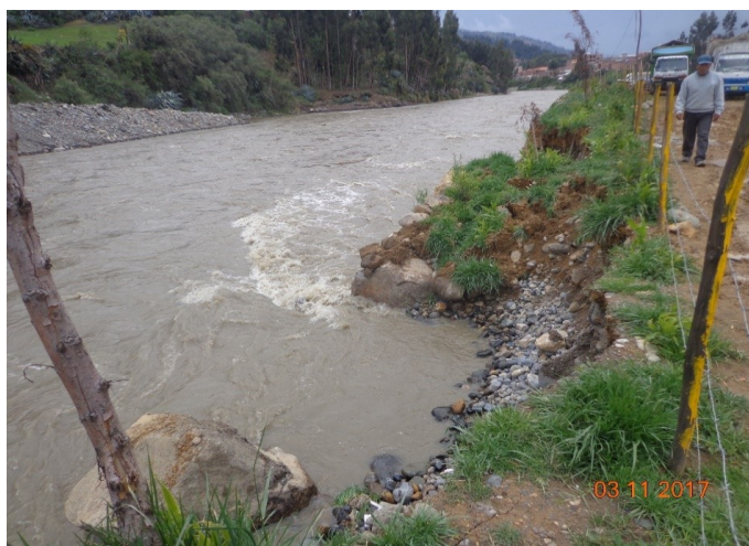
Figura 6. Suelos de relleno en el sector Challhua del río Santa
