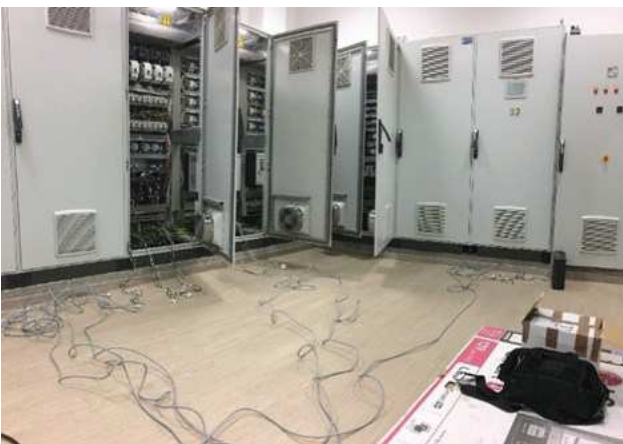
Figura 2: Medición de consumos eléctricos de los principales procesos en una de las EDAR analizada
