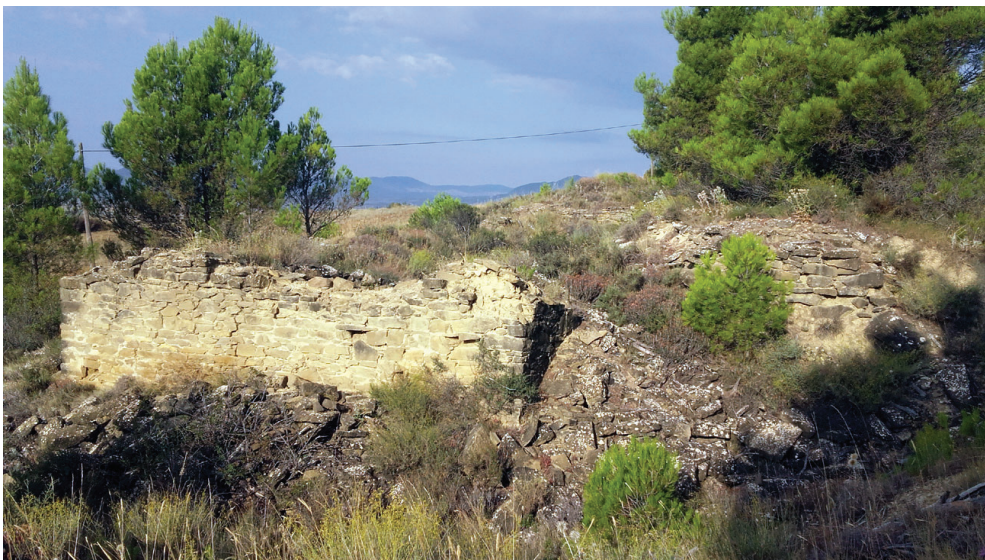
Ruinas de la ermita Santa Margarita, derecha de la imagen, y fuerte liberal de 1875, a la izquierda. Vista del lateral este. Fotografía: David Maruri 08.09.2018
