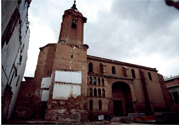
*Fig. 8. Estado de la torre de la iglesia parroquial tras el derribo del edificio del ayuntamiento.
