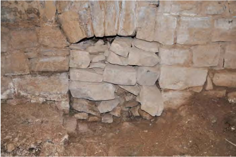
Vista de detall del canal de desguàs encara amb el tapiat intacte. Font: Iltirta Arqueologia SL.
