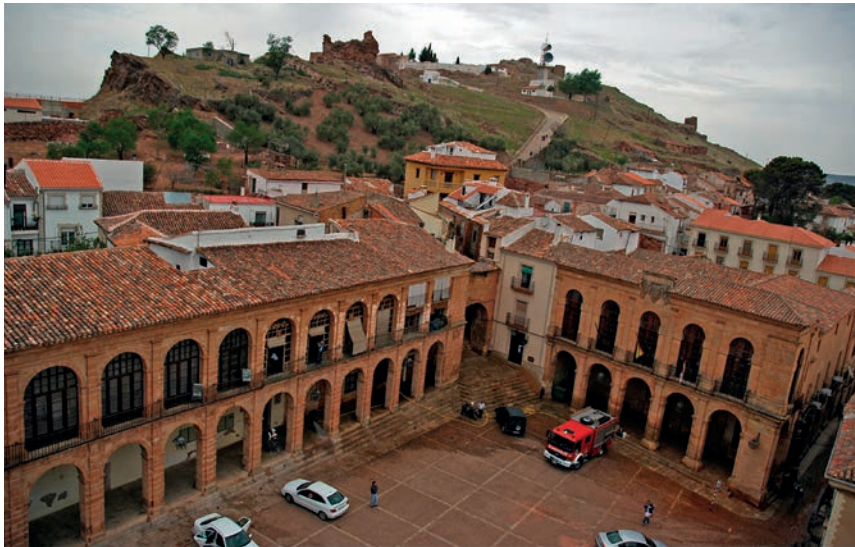
Alcaraz: los portales de las Carnicerías y la lonja del Alhorí, actual ayuntamiento, en cuyos precedentes trabaja Vandelvira en enero de 1527.
