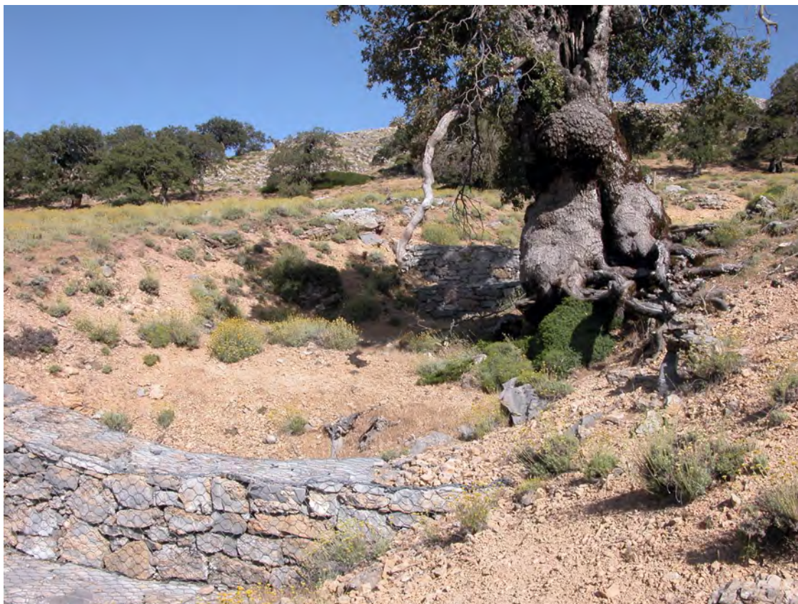
Los diques permiten consolidar el terreno y evitar las pérdidas de suelo y el consiguiente desarraigo.
