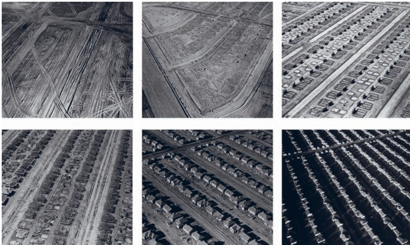
[Fig. 14]. Proceso de construcción de todo un asentamiento de nueva planta de la promotora de Louis Boyar, Mark Taper y Ben Weingart, en Lakewood, Los Ángeles. Fotografías de William A. Garnett, 1950. Fuente: Pacific Standard Time, The Getty.
