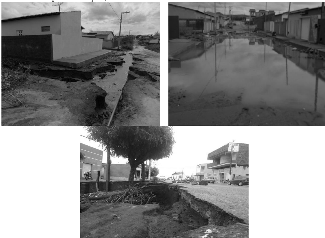
Figura 7: Danos causados pelas inundações, Catolé do Rocha-PB.
