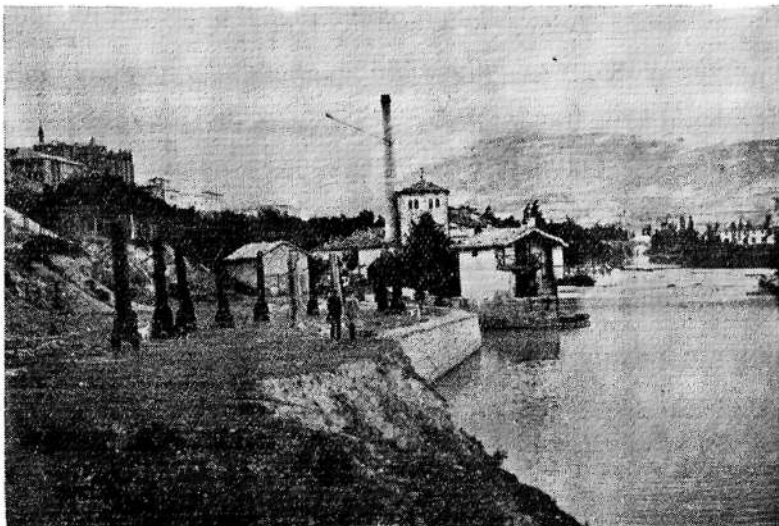
Foto n.º 1 - Vista del Molino de Caparroso, con la «punta de diamante» comienzo del «río de los leños», y soportes para colocar las cadenas. (Año 1899)
