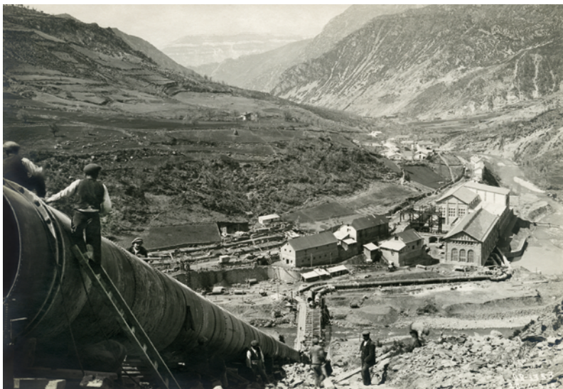
Ensamblaje de la tubería de presión de la central de Seira, construida entre 1912 y 1918. (Foto del 6 de abril de 1918, publicada en La aventura hidroeléctrica en el valle del Ésera , Huesca, DPH, 2012, p. 165. Colección particular).
