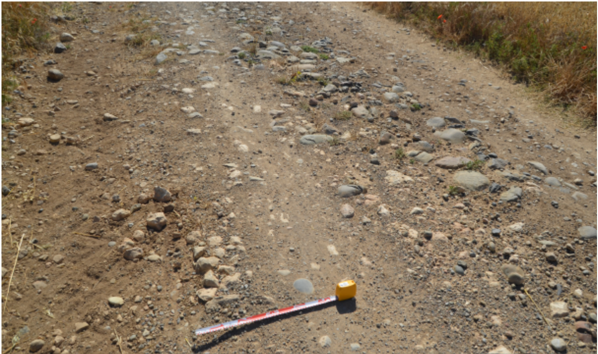
Fig. 21. Detalle de la estructura de cantos rodados del camino de La Sarda en el extremo oriental del sector 2. Obsérvese la fábrica de cantos rodados, bloques de caliza y grava, delimitada al norte por un bordillo de bloques de mayor tamaño (a la derecha). Esta estructura sin duda se prolonga enterrada en las fincas al sur del camino (a la izquierda).
