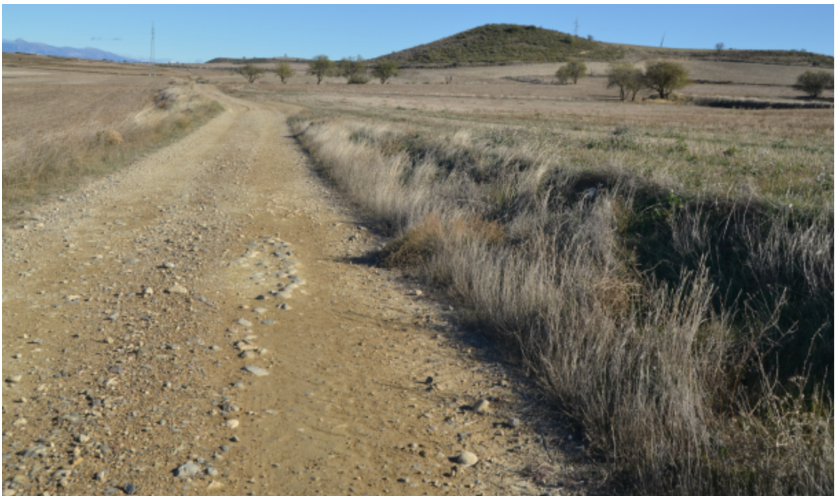
Fig. 33. Tramo occidental desde el sector 2. Concentración de cantos de río en el firme del camino actual, quizá perteneciente a la estructura del afirmado de la calzada (coordenadas 689.735; 4.657.396).
