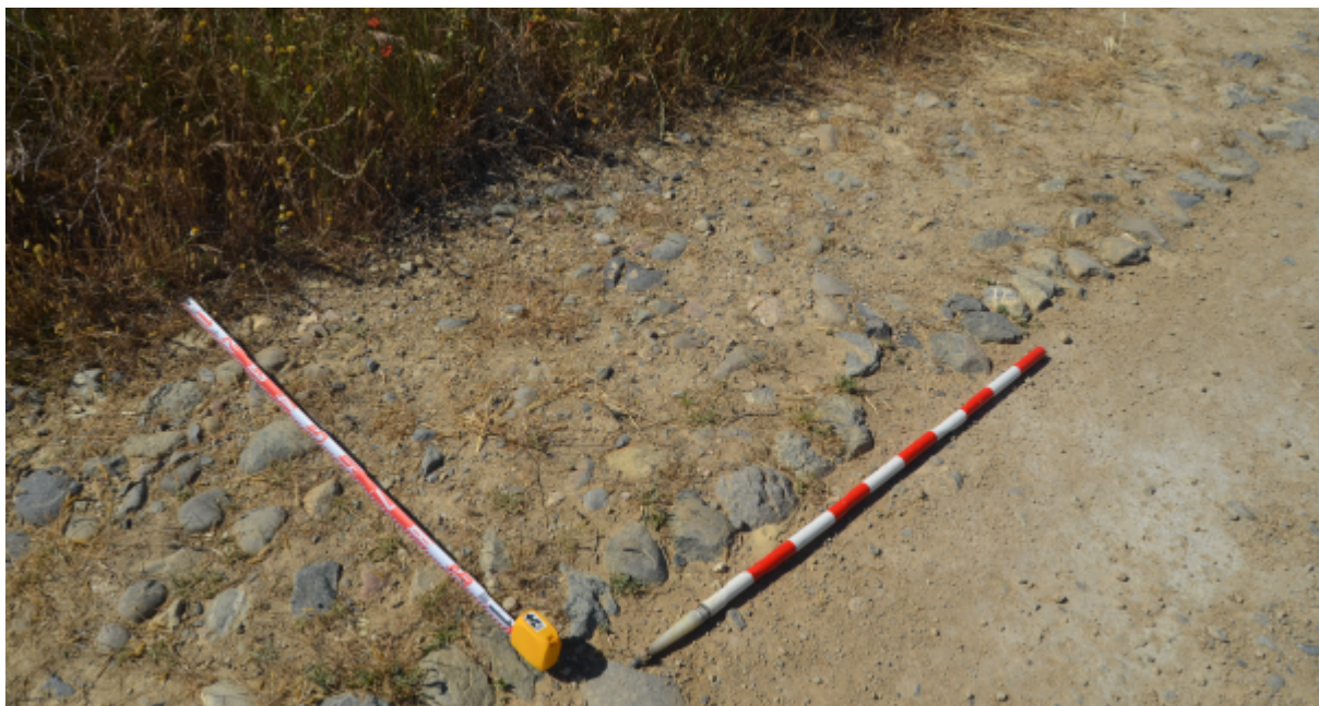
Fig. 25. Detalle de la composición de la segunda estructura de cantos del sector 2, vista desde el norte. Obsérvense su regularidad, su disposición rigurosamente rectilínea y la presencia de la alineación de bloques de mayor tamaño a modo de bordillo.
