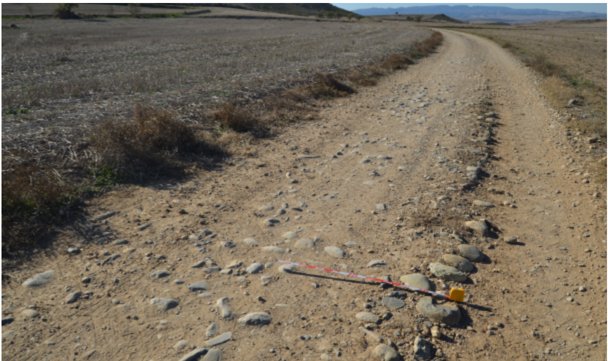
Fig. 20. Detalle de la estructura de cantos rodados del camino de La Sarda en el extremo oriental del sector 2 (coordenadas 690.370; 4.657.742). Obsérvese la fábrica de cantos rodados y grava, perfectamente horizontal, delimitada por un bordillo de bloques de mayor tamaño, que identificamos como una de las capas de la cimentación de la calzada. Esta estructura sin duda se prolonga enterrada en las fincas al sur del camino (a la izquierda de la imagen).
