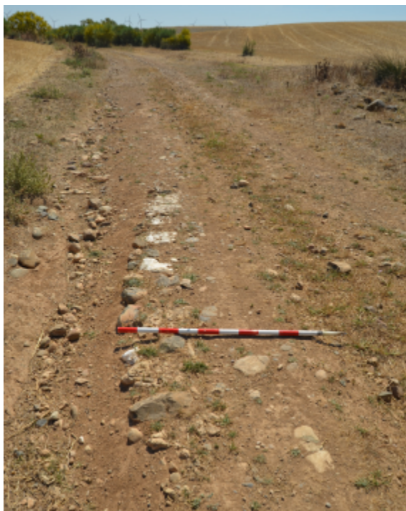
Fig. 40. Restos de la cimentación del afirmado de la calzada en el área occidental del sector 3 del camino de La Sarda, vistos desde el oeste. Está compuesta por un núcleo de cantos delimitado por un bordillo de grandes bolos y bloques escuadrados de piedra de yeso alabastrino.
