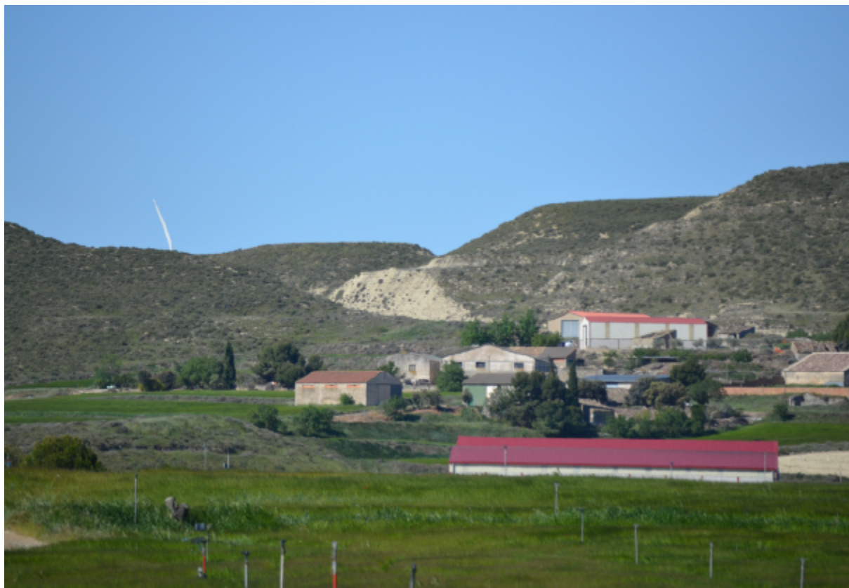
Fig. 11. Vista desde el noreste del desmonte de Alcalá de Gurrea por el que discurre el camino del monte de La Sarda, bien visible desde la carretera entre Almudévar y el embalse de Tormos.
