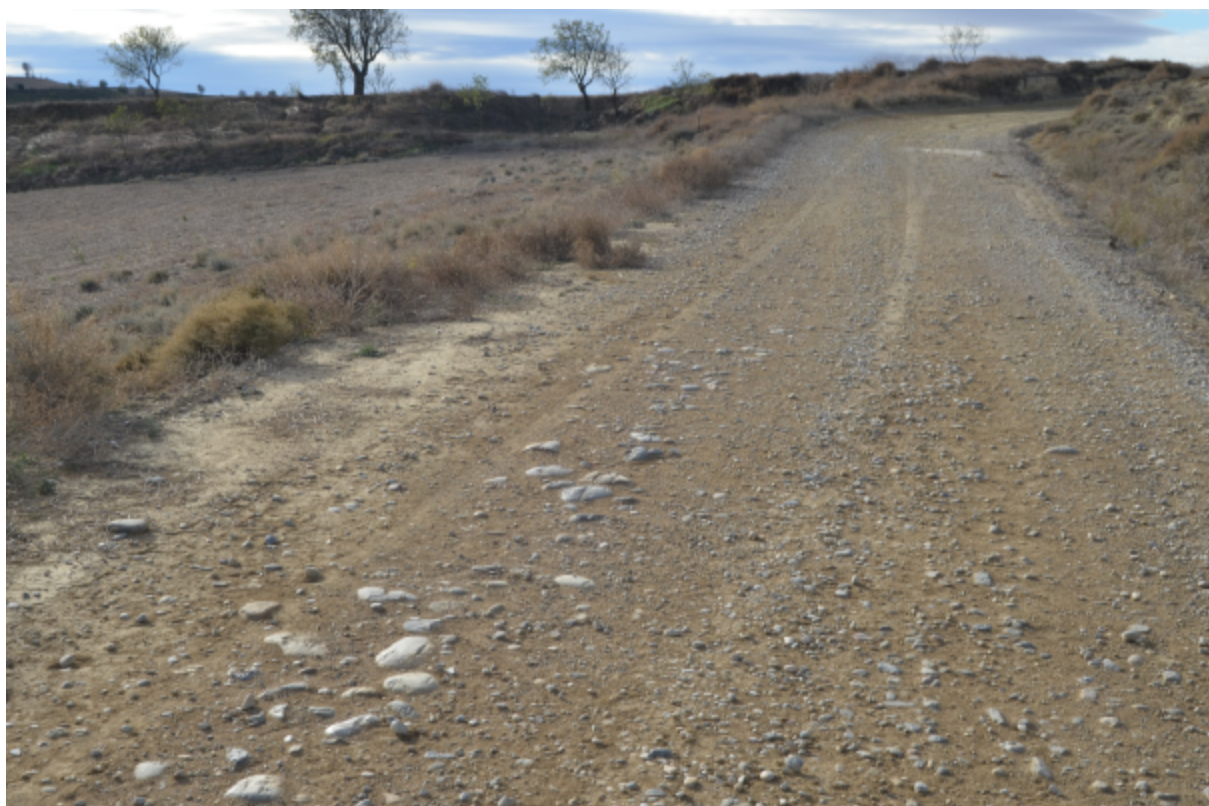
Fig. 18. Concentración de cantos rodados en la superficie del camino de La Sarda (coordenadas 691.425; 4.658.825), quizá pertenecientes a la estructura del afirmado de la calzada romana, aunque probablemente esta se localiza en la finca inmediata al sur.
