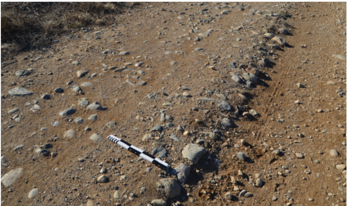
Fig. 22. Detalle de la composición de la estructura que identificamos como una de las capas de la cimentación del afirmado de una calzada romana. Obsérvese el mayor tamaño de los cantos del bordillo respecto a los del núcleo.
