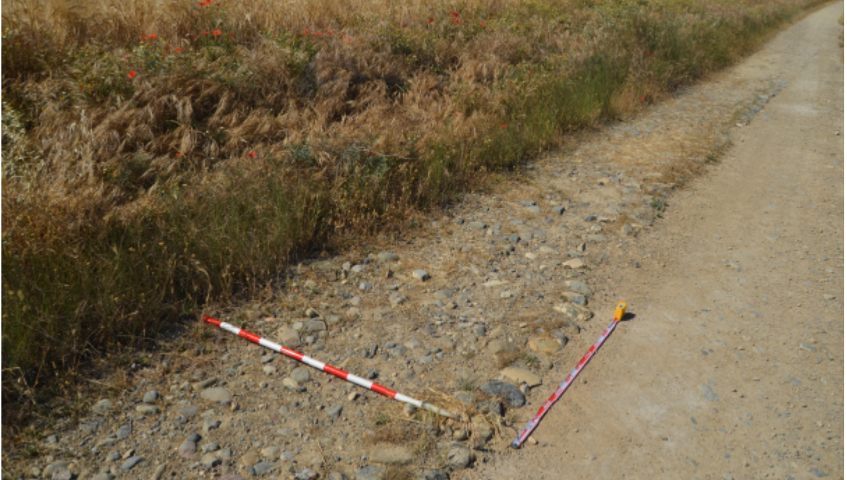
Fig. 23. Detalle de la segunda estructura de cantos del sector 2 (coordenadas 690.233; 4.657.670), la mejor conservada del conjunto, vista desde el norte, corresponde a una de las capas de la cimentación de la calzada de La Sarda. Obsérvense su regularidad, su disposición rigurosamente rectilínea y la presencia de la alineación de bloques de mayor tamaño a modo de bordillo.
