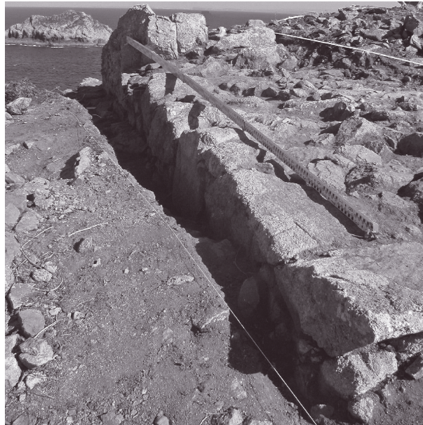
Fig. 8 Fundação norte da estrutura do sítio romano do Moinho.
