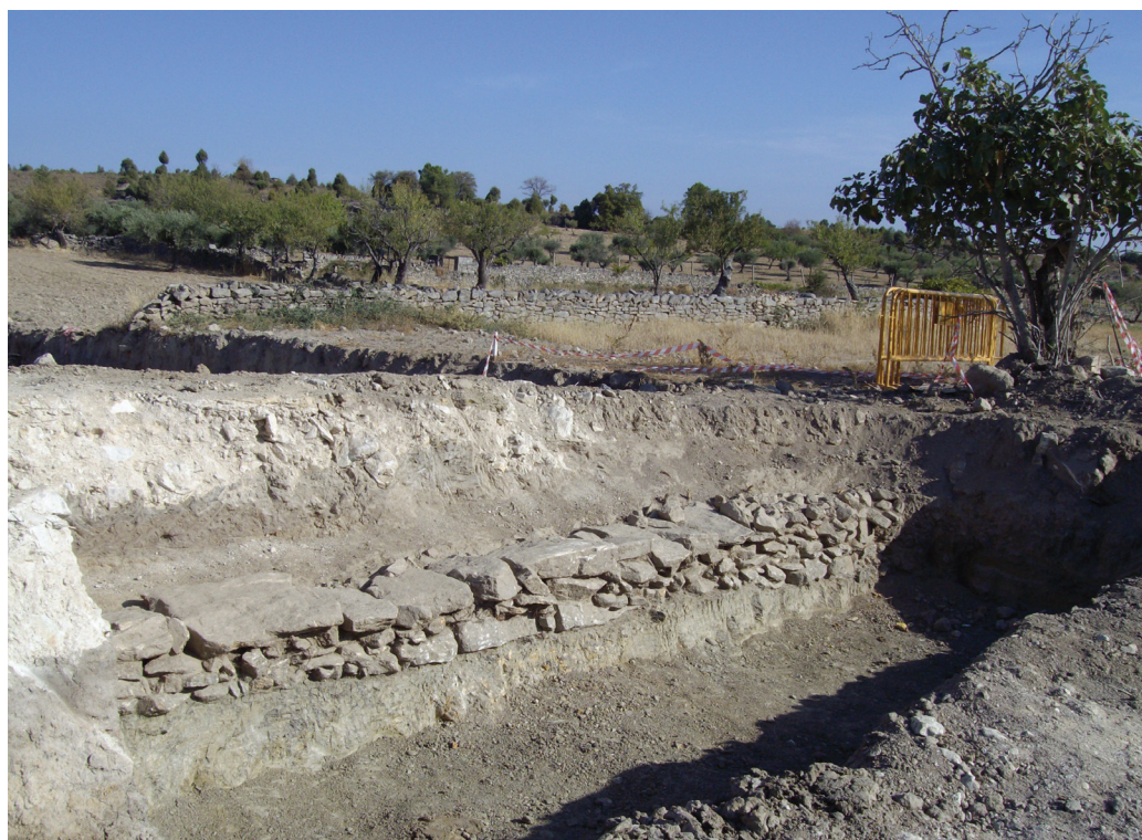
Fig. 9 – Pk 2+675 (lado direito da via). Alçado Estrutura 1.
