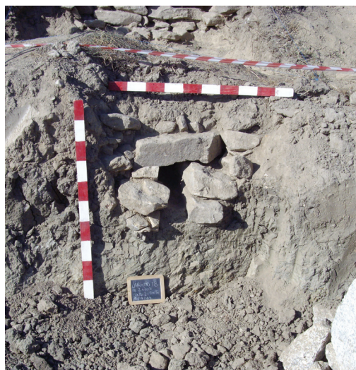
Fig. 10 – Pk 2+675 (lado esquerdo da via). Estrutura 2.
