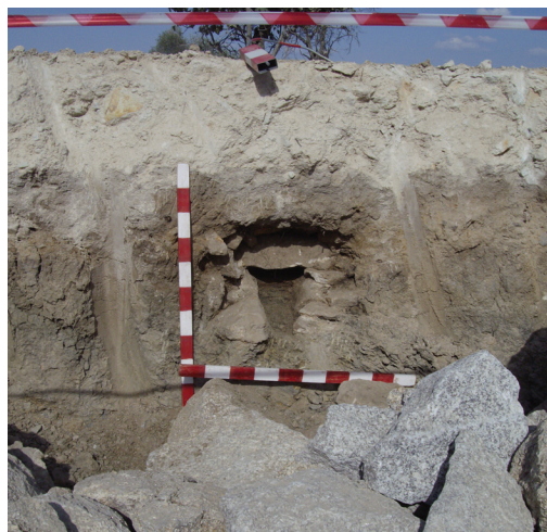
Fig. 4 – Acesso Definitivo da Margem Esquerda. PK 2+675 (lado direito da Via) – Estrutura 1.
