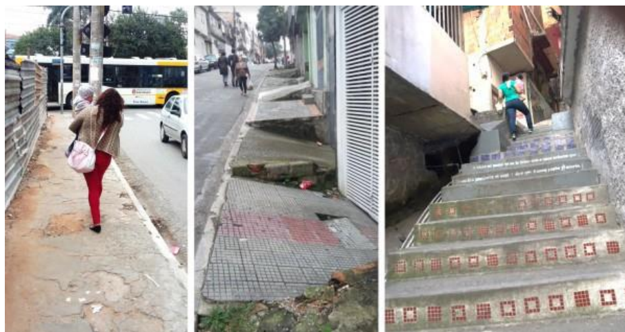
Imagen 3. Izquierda y centro: calles en São Paulo, Brasil (Fotografías de la autora). Derecha: escaleras en Caracas, Venezuela (Fotografía de Leonardo Yáñez)
