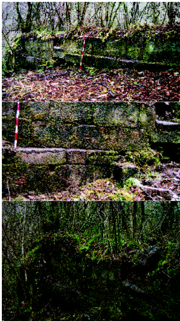
Fotos 1, 2 e 3.- De arriba abaixo: vista xeral do muro N, marcas de canteiro e desviación da base con respecto ó muro.
