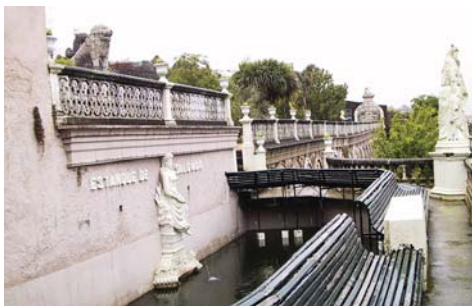
Imágenes del parque durante las obras y una vez finalizadas.
