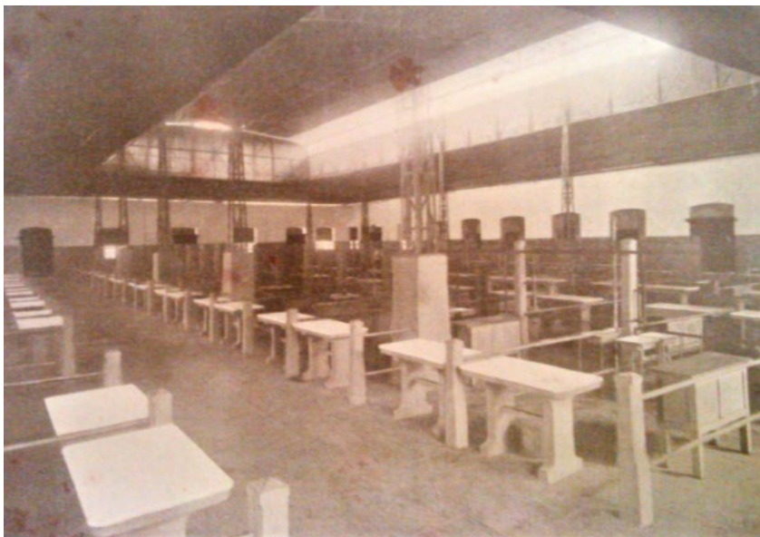
Figura 4. Instalaciones del nuevo Pabellón de Carnes del Mercado Público
