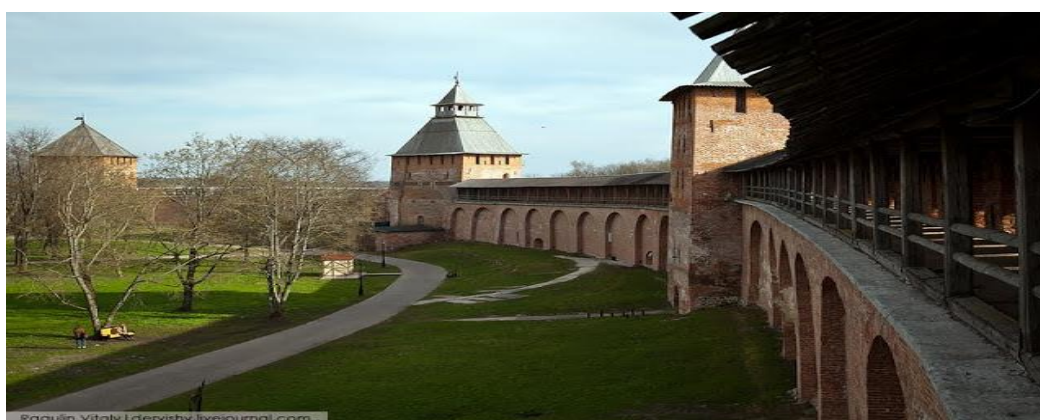
Figura 9. Vista interior del Kremlin de Nóvgorod en la actualidad 75 .
