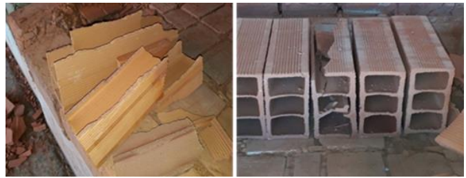
Fig. 15. Choque térmico por alto contenido de humedad en los bloques.
