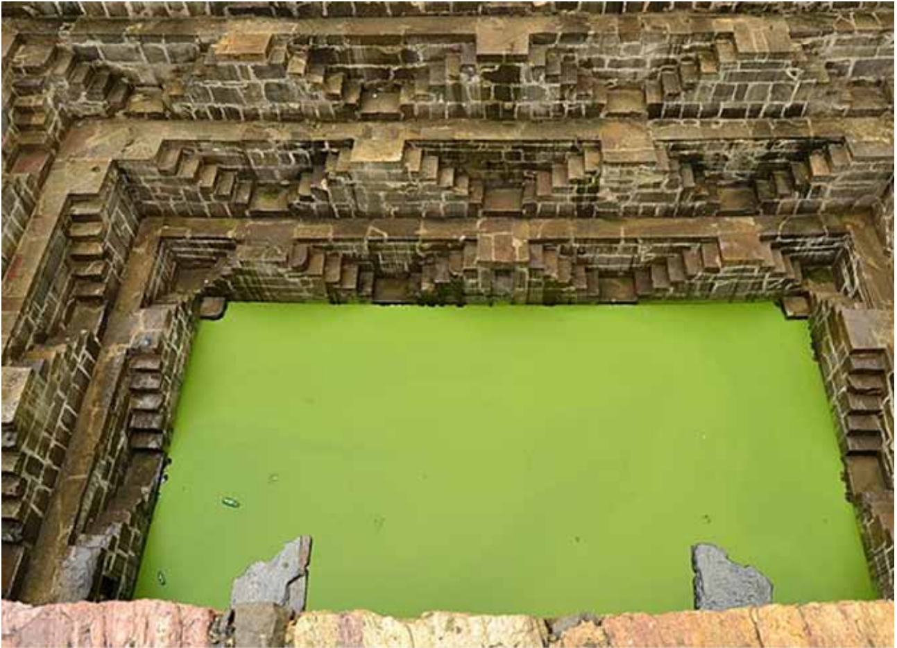
Vista de los escalones a distintos niveles que tiene el pozo de la mina Chand Baori
