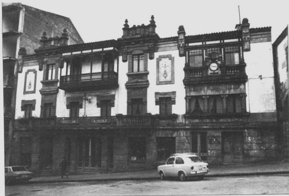
Casa Núñez. Fachada, 1923.
