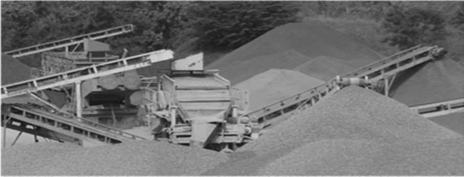
Planta productora de agregados, la arena, constituye a su vez una materia prima del hormigón
