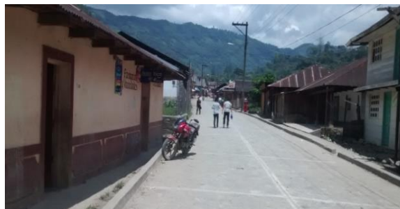
Figura 6. Calle Pavimentada. Fuente: trabajo de campo.
