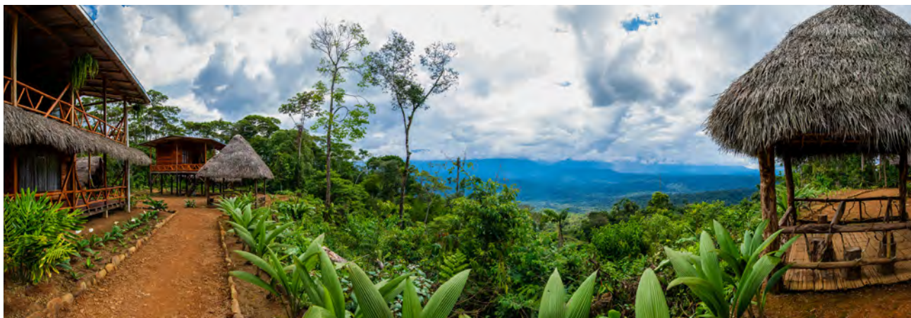
Las construcciones en zonas selváticas de Ecuador se realizan aprovechando los recursos a mano, como las cañas guadúa, madera y hojas de palmera.
