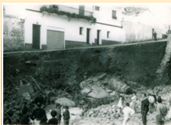
A la derecha, se puede comprobar el perfil de la cerca de mampostería
