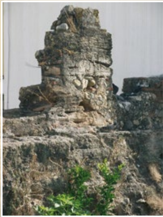
Imagen del paramento de protección del paso de ronda
