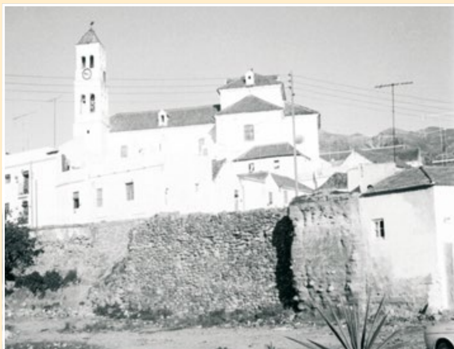
La torre Nueva construida de tapial y la cerca parcialmente destruida construida con mampostería
