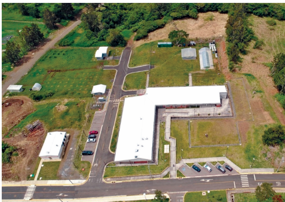
Figura 1. Fotografía área del Centro de Investigación en Biotecnología. Detrás del edificio principal se encuentra la zona de microalgas y a la derecha el campo frutícola.
