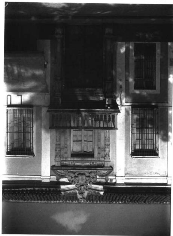
Lamina 2. Portada de la casa de los Cavaleri. Fototeca del Laboratorio de Arte.
