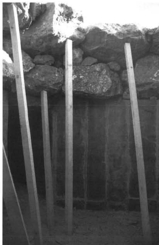
Fig. 7: El dolmen, una vez forrada la cámara e inicio de la construcción de la bóveda.
