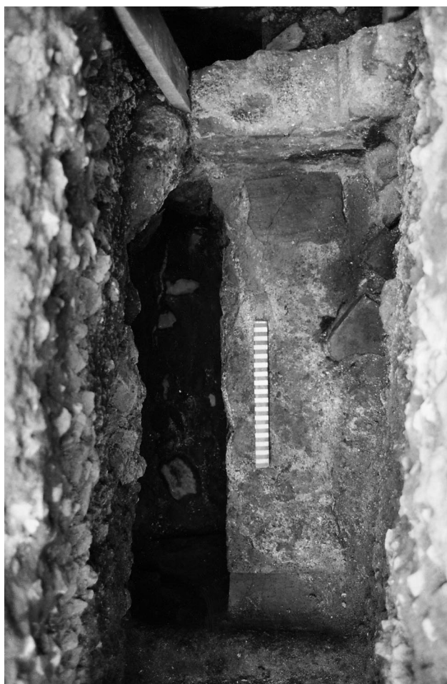
Fig. 13 Particular do muro, murete e pavimento da Sondagem 7 visto de Sudeste.
