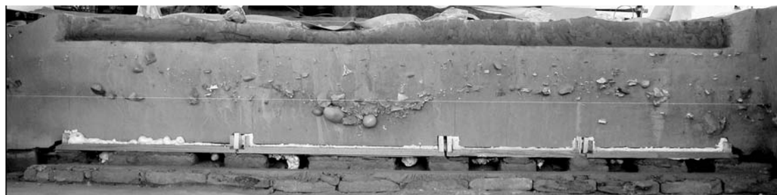
Fig. 36 2.ª Fase de Trabalhos no Testemunho.
