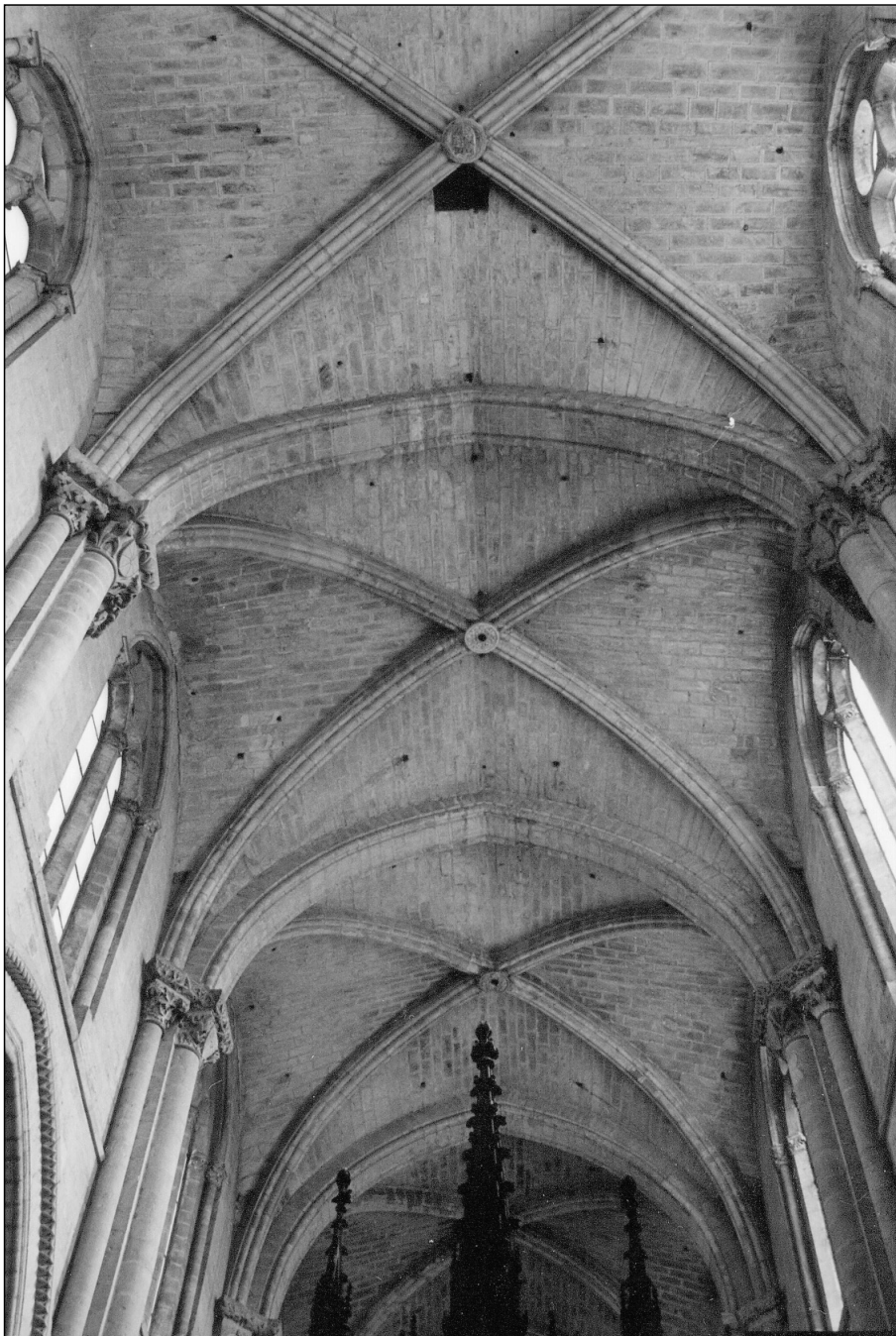
Lámina 11. Tudela. Catedral. Bóvedas de la nave mayor
