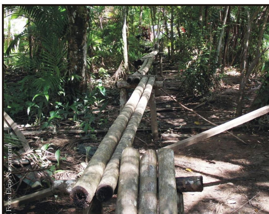
Foto 02. Pontes construídas com o caule do açazeiro, utilizados pelos moradores da comunidade quilombola do Baixo Acaraqui Fonte: Pesquisa de campo (2012).
