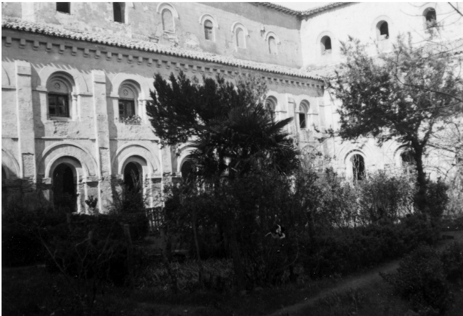
Claustro del monasterio. Vistas de las fachadas construidas según el proyecto de la comisión. 1932-1936. (Arxiu Nacional de Catalunya, Institut Escola)
