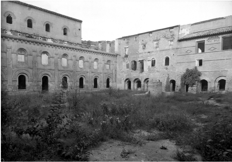
Claustro del monasterio. Vista de una de las fachadas antiguas y una de las construidas según el proyecto de la comisión (a la izquierda). (Archivo Histórico Provincial de Zaragoza, AHPZ_MF_MORA_3074. Foto: Juan Mora Insa. © Gobierno de Aragón)
