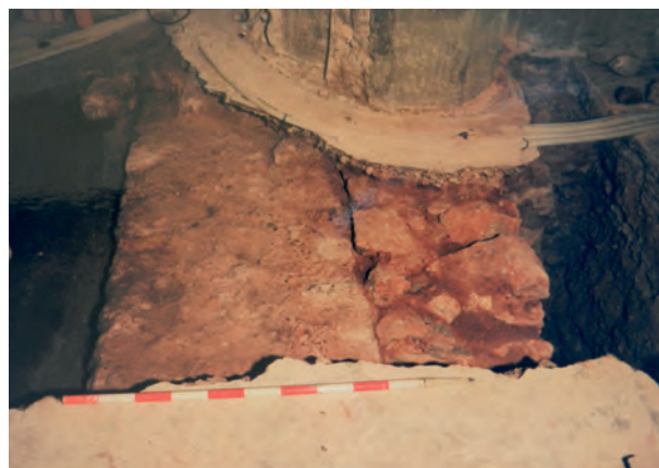
Figura 13. Vista del mur meridional de la primera església de Santa Maria reforçat després amb un altre mur de pedra in situ.
