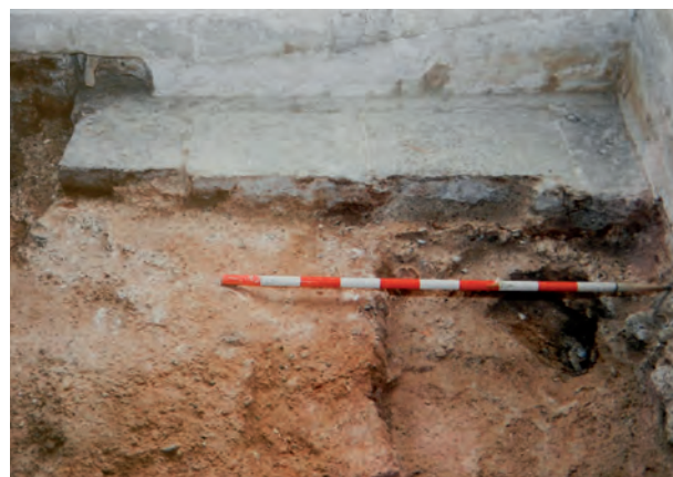
Figura 15. Detall del paviment de lloses de pedra que tenia l'església al segle XV.
