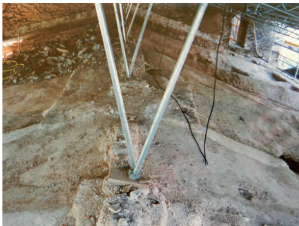
Figura 6. Vista del seguiment arqueològic en la coberta de l'església.
