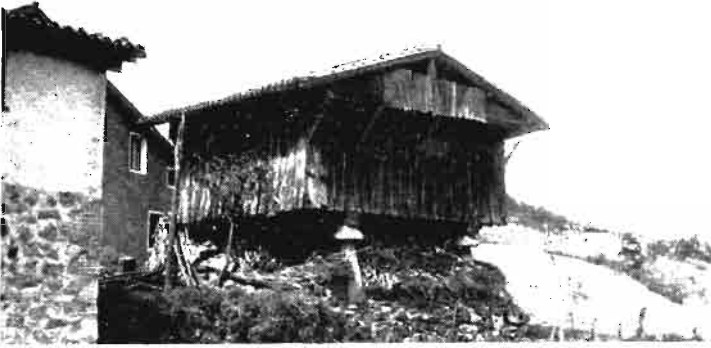
Foto núm. 11.—“Garaixe” del caserío de Iburgüen. Markina - Etxeberria - Vizcaya.
