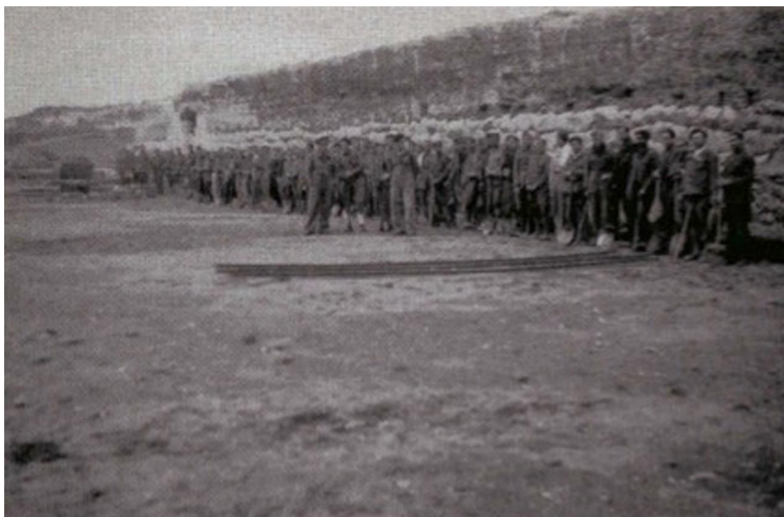
Figura 3. Início das escavações em Ampúrias em 12 de setembro de 1940. O batalhão de trabalhadores Figueiras 71. A frente observa-se as vias férreas para o deslocamento dos vagões (GRACIA-ALONSO, 2003, p. 279).
