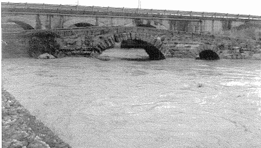
Riada del Arroyo Salado. Noviembre de 1997. En primer término el puente romano y detrás, el puente actual.
