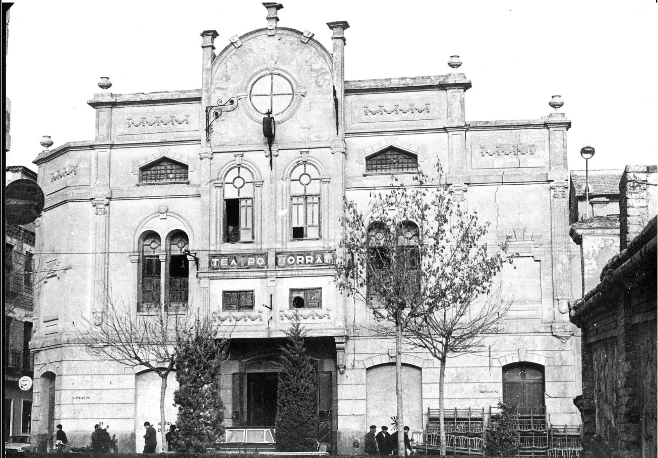
Fachada del Teatro Borrás poco antes de su demolición.
