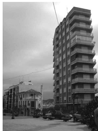
Edificio de 10 plantas construido en los años 70 frente al Convento.
