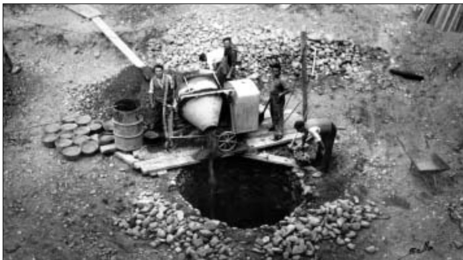
Figura 2.- Fotografía del pozo del Mercadal obtenida durante las obras de la casa del paseo del Mercadal números 12 y 14 . Nos ha sido facilitada por ‘Foto Bella’ & Arturo Pérez Fernández.
