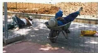
Las obras del macro hospital para detener el coronavirus en España, siguen el ritmo previsto. Les seguiremos informando.
