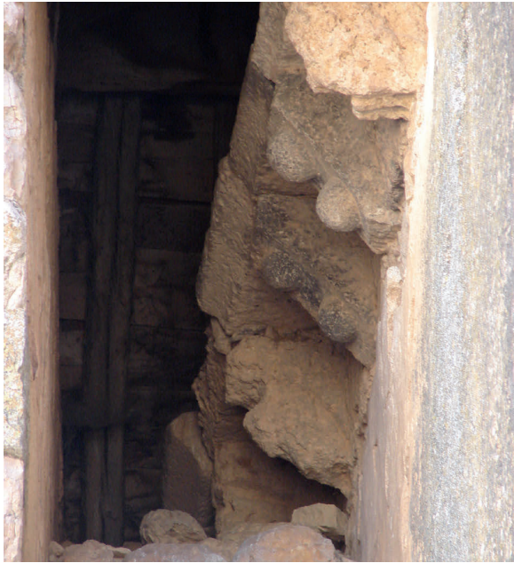
Ilustración nº 25. Canecillos del alero de la nave justo por encima de la antigua salida de la (hoy) elevada portada norte que daba acceso a la tribuna perimetral, apenas entrevista por un murete posterior que se adosó entre la nave y la torre. Fotografía tomada en 2009
