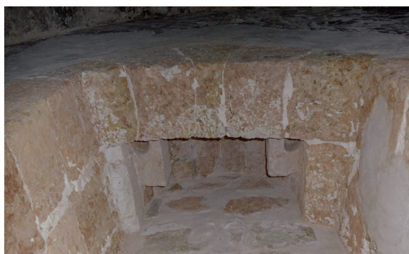
Ilustración nº 24. Quicialeras de la portada norte, vistas desde la actual sacristía (cuerpo bajo de la torre)
