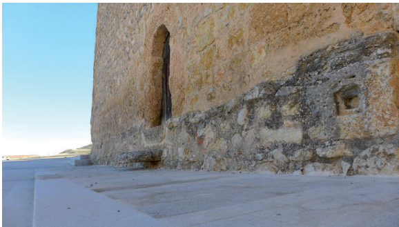
Ilustración nº 20. “Escalón” y loculus (en primer plano) después de la intervención (año 2020)
