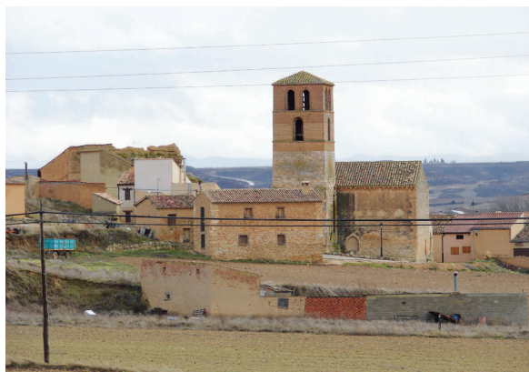
Ilustración nº 13. La iglesia vista desde su costado norte. Se aprecia la gran altura de la nave (el cuerpo que se ve a la derecha de la imagen)
