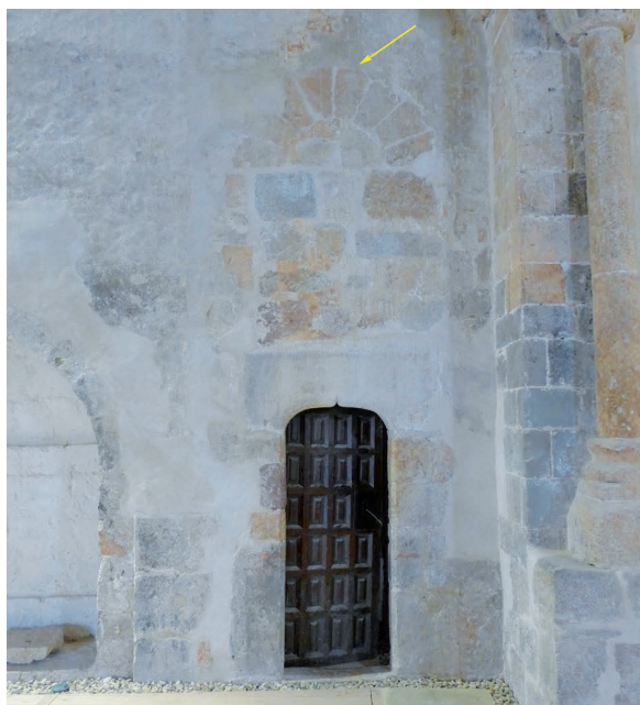
Ilustración nº 22. Portada elevada norte vista desde la nave, cegada y parcialmente destruida en su parte inferior para abrir la actual de la sacristía hacia el año 1500
