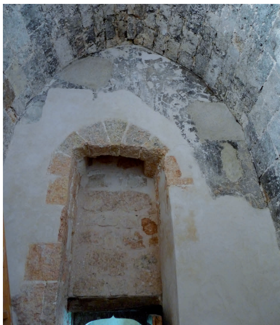
Ilustración nº 23. La misma portada norte vista desde la sacristía (en origen, exterior del templo)
