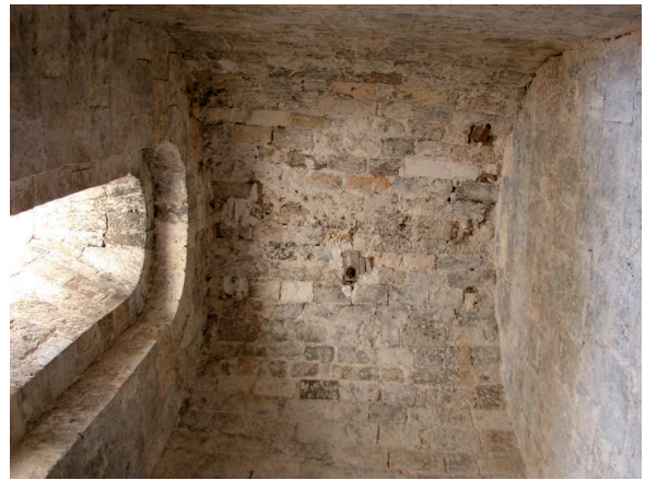
Ilustración nº 26. Bóveda de medio cañón de la parte baja de la torre, luego sacristía, con ventana románica de acusado derrame
