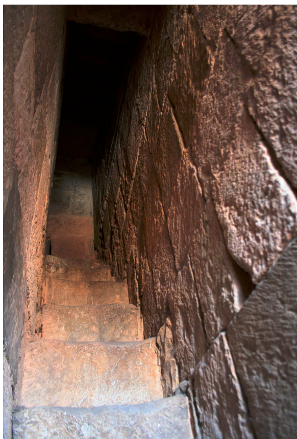
Ilustración nº 27. Estrecha escalera románica de la torre, embutida en el espesor del muro
