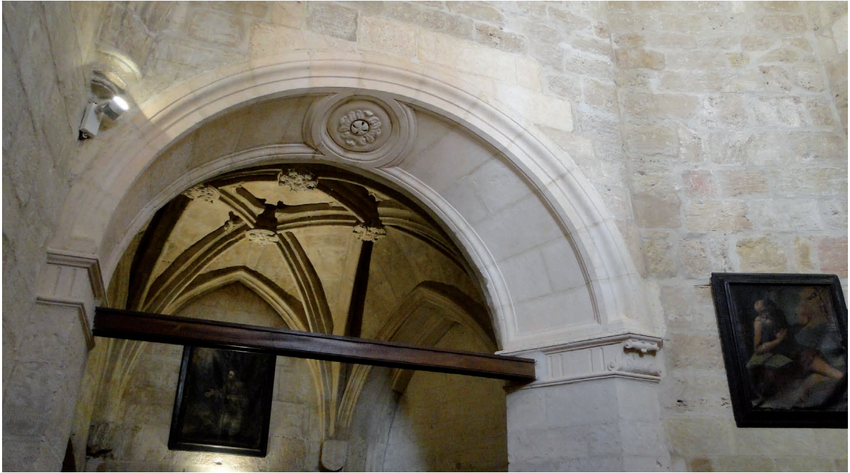
Fig. 5. Arco en esviaje en la sacristía de la iglesia de Santa María de Aranda de Duero.
