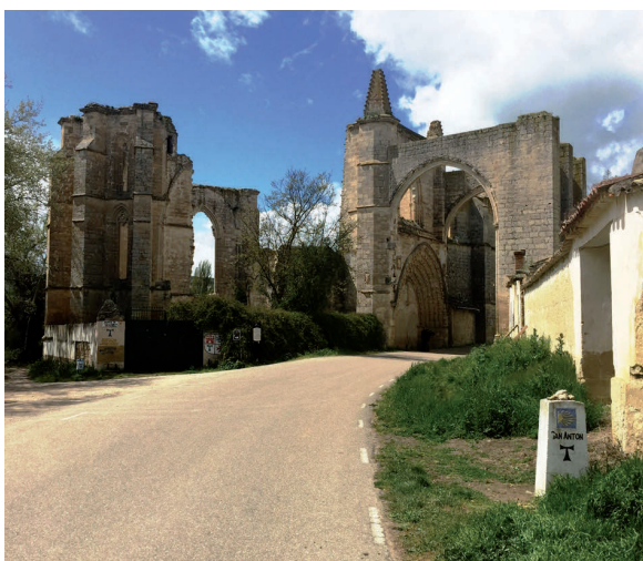
Fig. 4. San Antón de Castrojeriz (Burgos).
