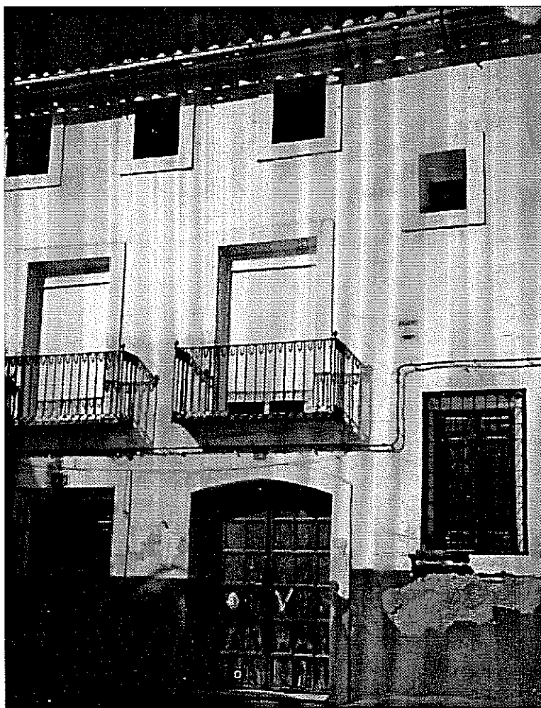
Estado actual de la Casa de la Encomienda.
