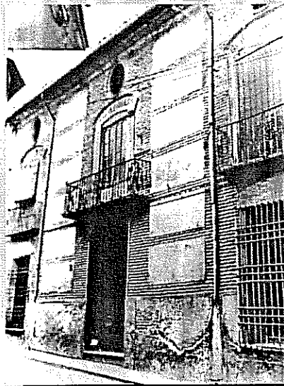
En la calle Mesones se ubicaba esta casa de estilo barroco murciano, la antigua Casa de Postas. Derribada en la década de los 80.
