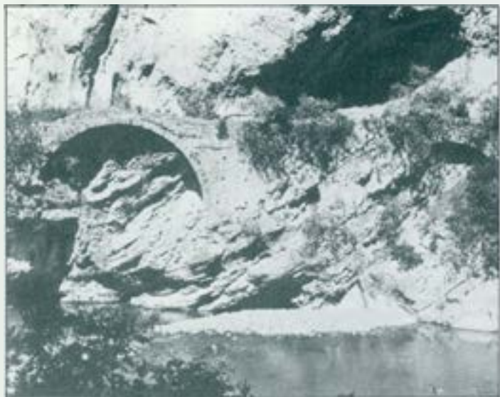
Arc d'obra per eixamplar el camí al congost dels Tres Ponts, al Segre.
