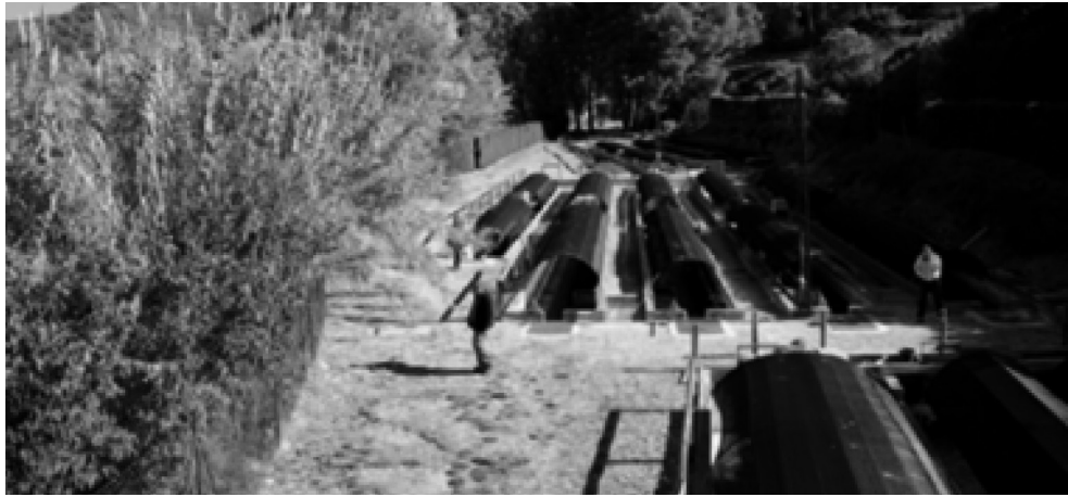
Vista general de tanques preengorde de trucha. Instalaciones GVA en Tuéjar (Valencia)
