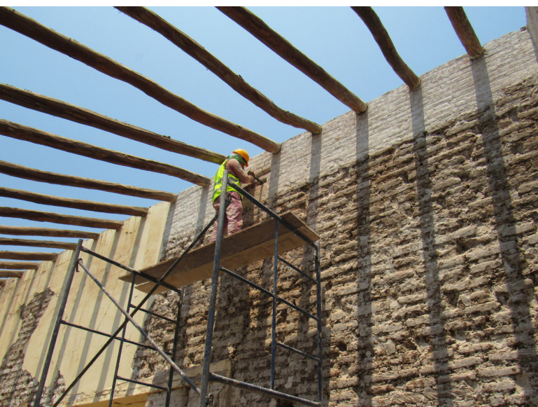
Figura 6. Al retirar los revestimientos se observó que los daños en las viviendas de adobe no fueron graves (Cooperación Comunitaria)
