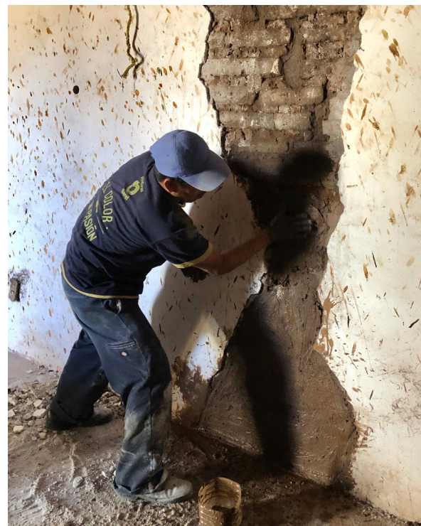
Figura 12. Relleno de grieta y saneamiento de revestimiento con tierra estabilizada con hidróxido de calcio (Cooperación Comunitaria, 2019)
