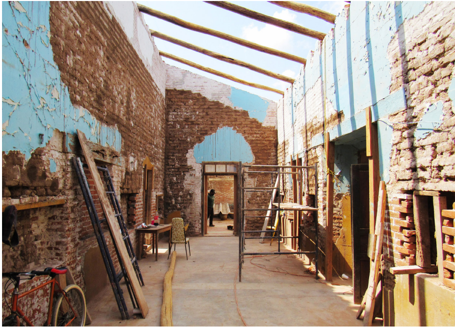
Figura 5. Inicio de intervención en una casa monumental de adobe (Cooperación Comunitaria, 2019)
