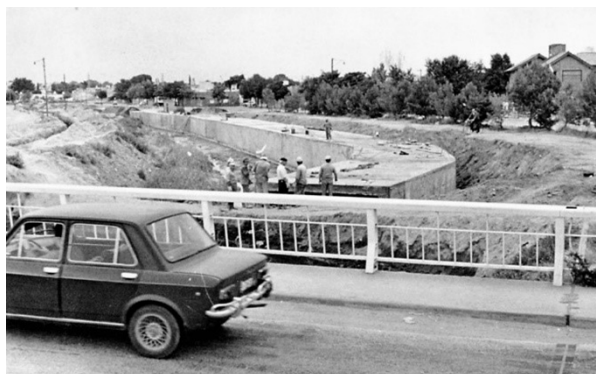
Primera etapa de la realización del entubado del arroyo en calles Brown y Estados Unidos (1978)
