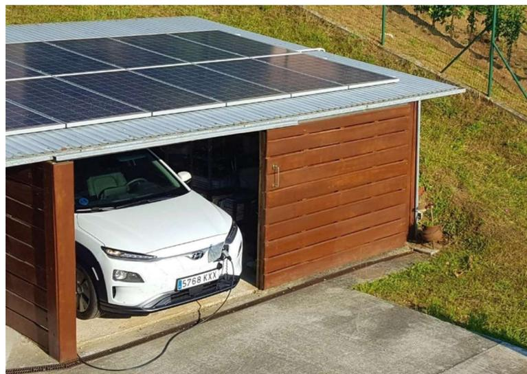
Instalación doméstica de autoconsumo fotovoltaico de 6,6 kW empleada en la recarga del vehículo eléctrico. Comarca de Ferrolterra, julio de 2019
